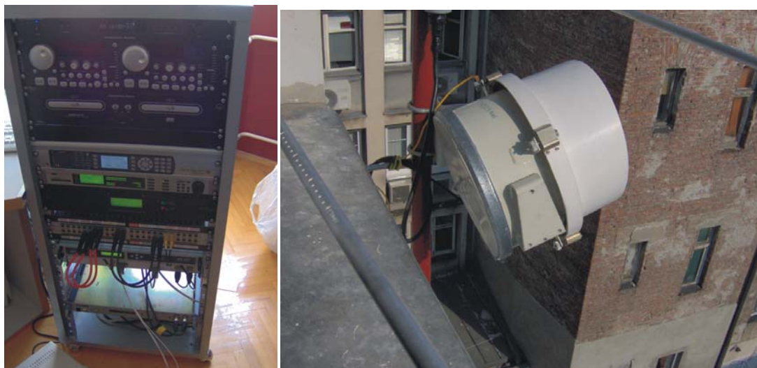
Slika 2. Predajna strana: IDU jedinica u studiju i ODU jedinica na bočnom zidu
